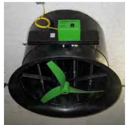
Abluftklappe mit Messtechnik
