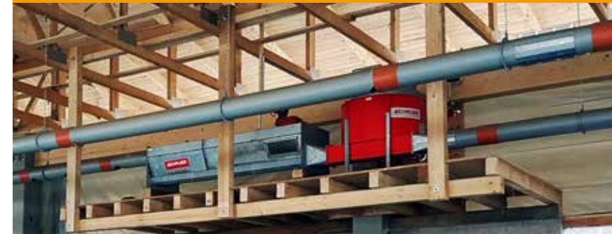
Übergabeeinheit und Antriebseinheit
