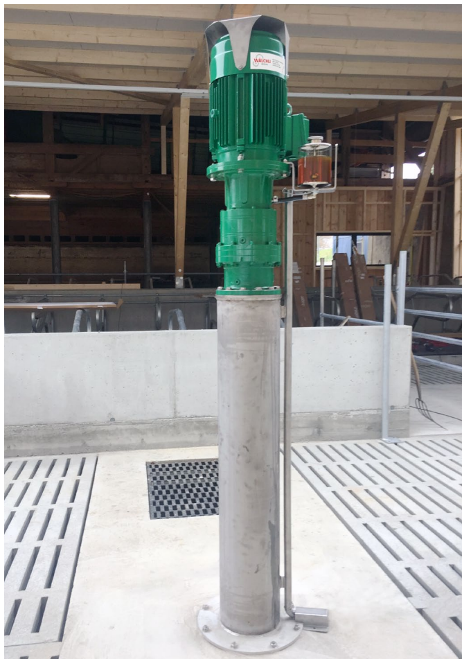
Erhöhte Montage auf Konsole im Laufstall
