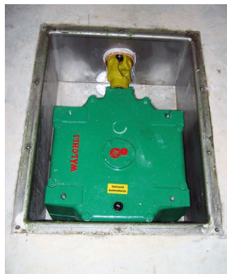
Versenkte Ausführung mit Seitenantrieb
